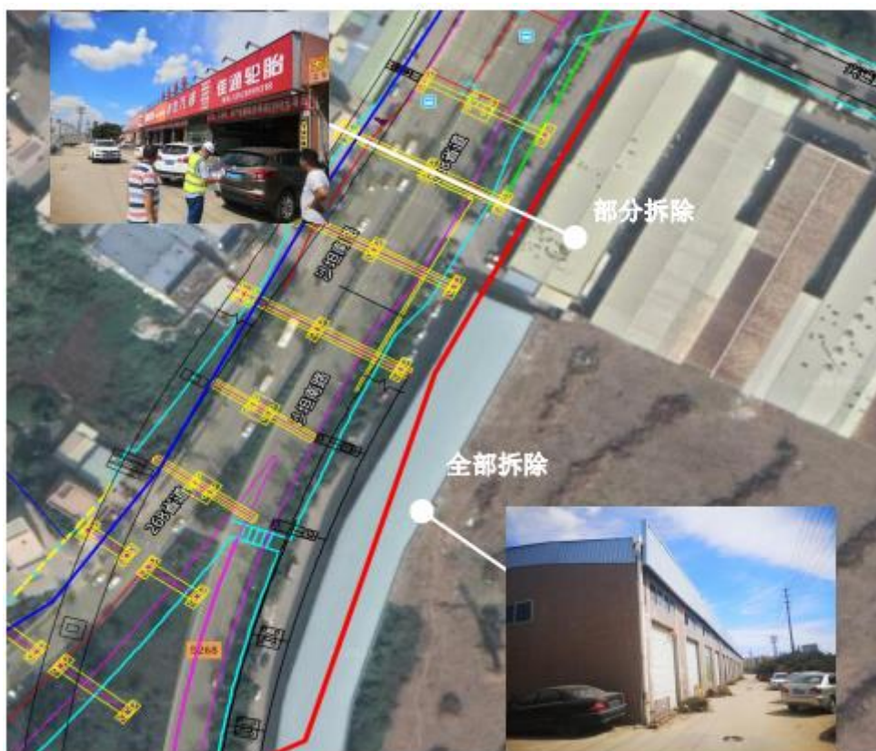
图 3.1-4 坦洲快线东侧拆除房屋示意图（蓝色为原管道、红色为迁改管道）
