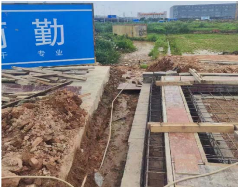
洗车槽（建设中）
