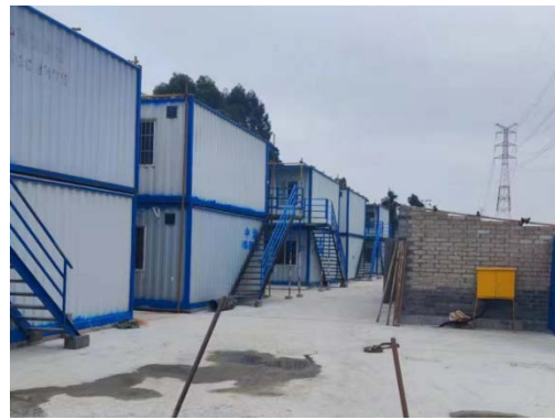
施工营造区（已建成）
