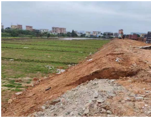
填方边坡现状
