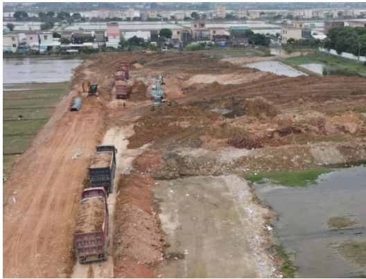
主体工程区现状
