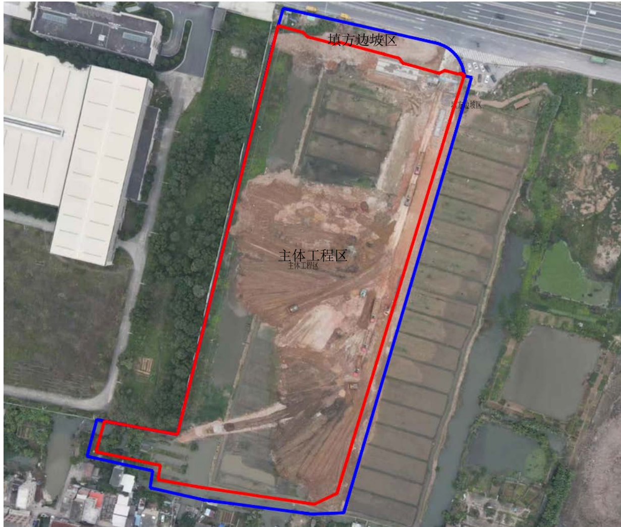
项目区航拍照片（日期 2022 年 11 月） （红线范围为主体工程区，蓝线范围为填方边坡）
