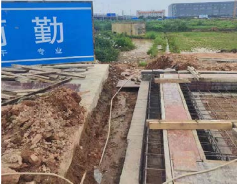
洗车槽（建设中）
