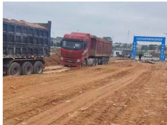
主体工程区现状
