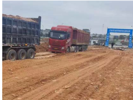
主体工程区现状
