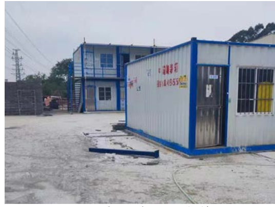
项目施工营造区现状
