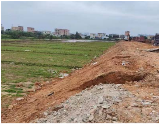
填方边坡现状
