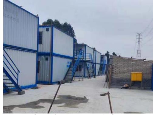
施工营造区（已建成）
