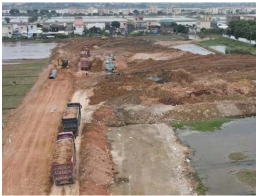
主体工程区现状
