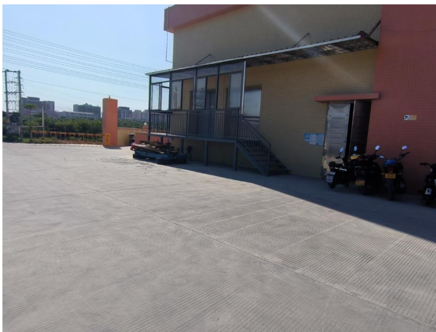
图 4.7-1 厂区占地范围内地面硬化照片
