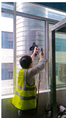
搅拌、倾倒、压料、投料、称料工序废气 处理后排放口
