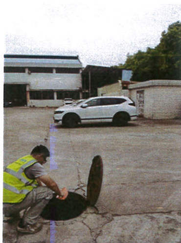
生活污水采样
