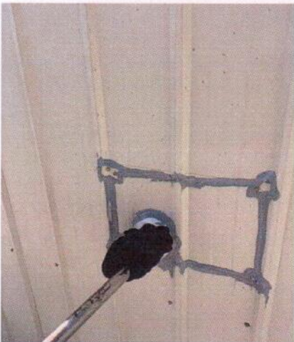
金属激光切割 (开料) 工序废气 排放口 (DA003)
