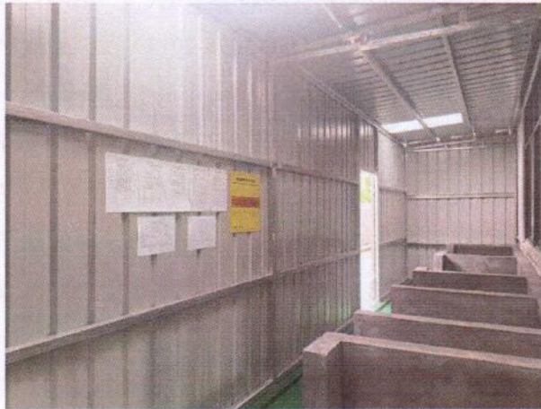
危险废物贮存间
